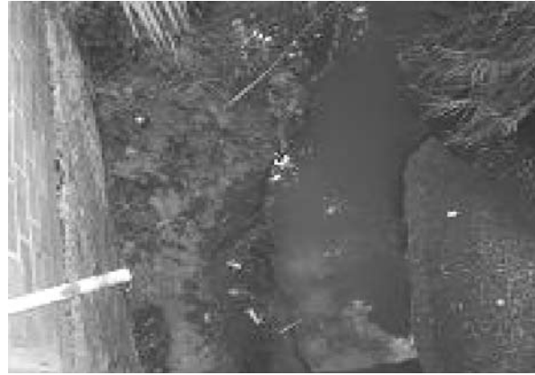
FOTOGRAFÍA 5. FOTOGRAFÍA 5 Y 6.- CONDUCCIÓN DE AGUAS RESIDUALES POR LOS CAUSES NATURALES DE ARROYOS, NÓTESE EL TUVO PVC DE UNA DESCARGA DOMÉSTICA AL CURSO DEL ARROYO.
