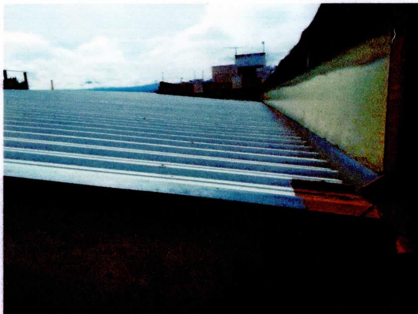
**Figura 4. Vista de parte del techado, canaleta y baja de agua, del mercado Benito Juárez.**
