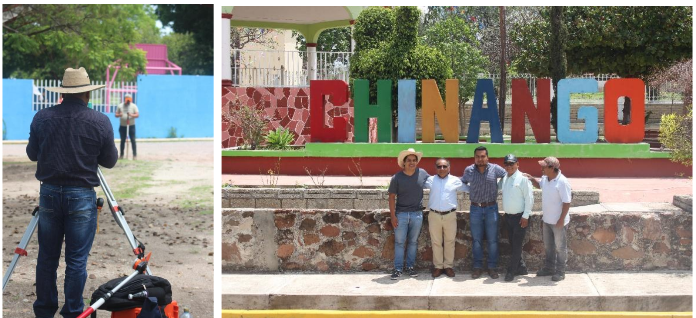
Figura 16 Levantamiento topográfico para nivelar un terreno que se utilizará para un mercado comunitario en Santa Catalina Chinango, Tequixtepec, Oaxaca.
