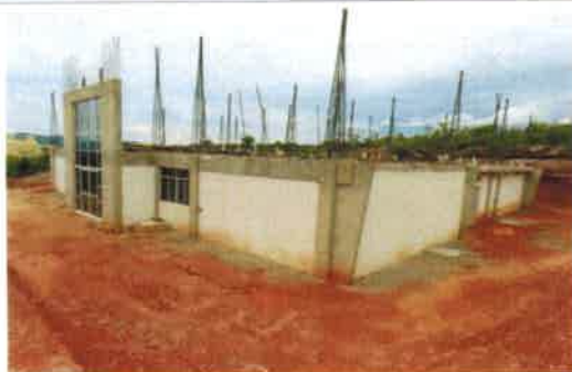
F1: VISTA 1 TERRENO
