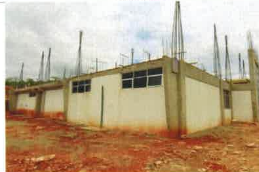
F4: VISTA 4 TERRENO
