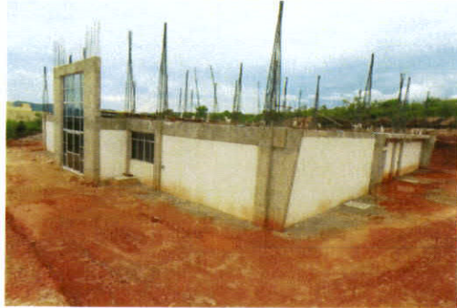
F1: VISTA 1 TERRENO
