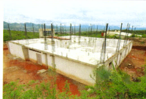
F2: VISTA 2 TERRENO
