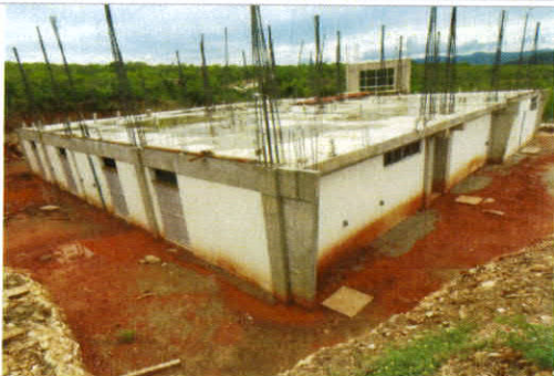
F3: VISTA 3 TERRENO
