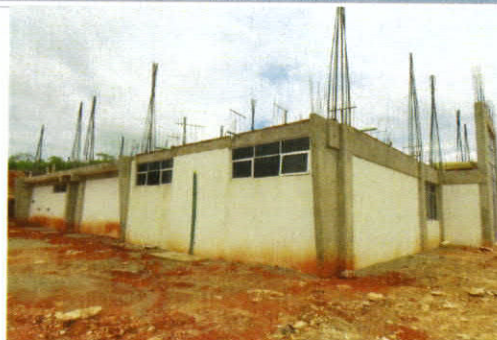
F4: VISTA 4 TERRENO
