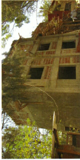
F2: VISTA 2 CONSTRUCCIÓN
