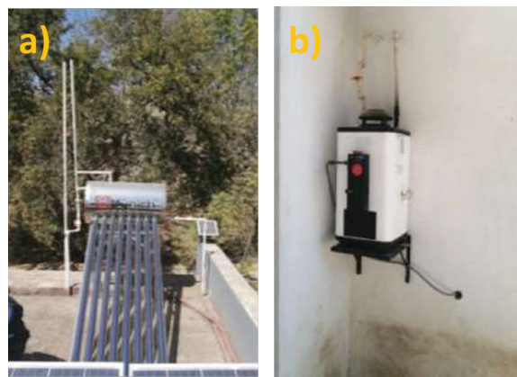
Figura 9. Instalación incorrecta de by pass. a) y b) Villa de Zachila. Fuente: Elaboración propia.
