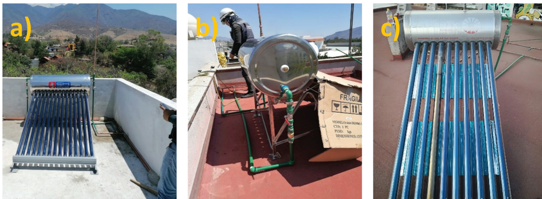
Figura 8. Calentador solar instalado sin válvulas anti-quemaduras: a) Tlacolula de Matamoros, b) San Antonio de la Cal y c) Cd. de Oaxaca de Juárez. Fuente: Elaboración propia.
