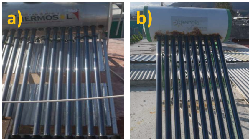
Figura 4. Efecto de la mala orientación de los calentadores solares: a) Santa Lucía del Camino, b) Cd. De Oaxaca de Juárez.
