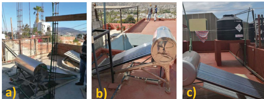
Figura 5. Evidencia fotográfica de instalación con sombras: a) Santa Lucía del Camino, b) Cd. De Oaxaca de Juárez y c) San Antonio de la Cal.
