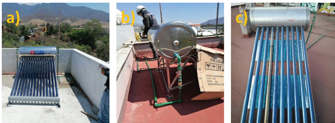
Figura 8. Calentador solar instalado sin válvulas anti-quemaduras: a) Tlacolula de Matamoras, b) San Antonio de la Cal y c) Cd. de Oaxaca de Juárez. Fuente: Elaboración propia.
