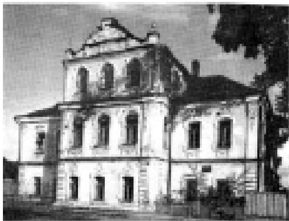
Figura 2. Edificio solo. Un ejemplo de imagen integral "agradable para el ojo humano"
